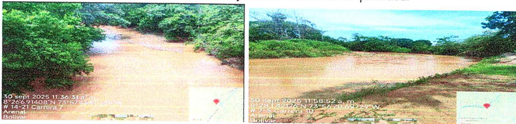
Figura N°4 y 5. Instalación de motores en sobre la quebrada arenal y erosión de en la ribera del cauce.”
